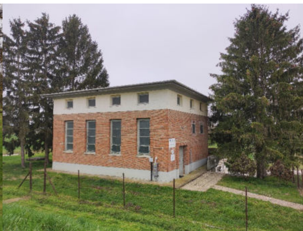
13. ábra: Árpási szivattyútelep
